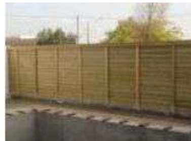
Barrière de protection pleine
