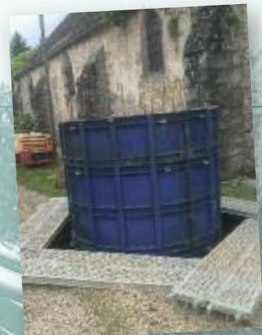
Photo 1 : Création du poste de refoulement
