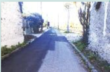
Photo 6 : Route de Bellanger après travaux
