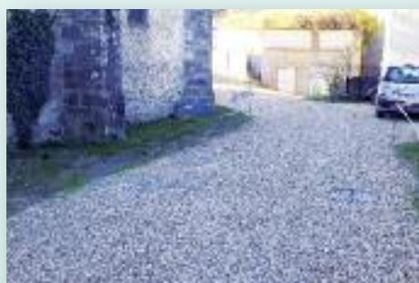
Photo 4 : Place de l'Eglise après travaux
