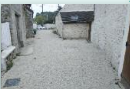
Photo 5 : Impasse de la Mairie après travaux
